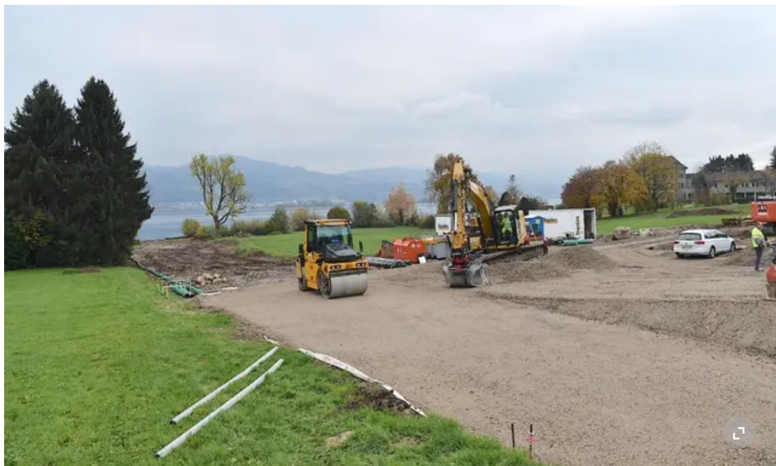
Die Bauarbeiten auf dem Grundstück der Federers in Rapperswil haben schon angefangen, als die Einsprache einging. Foto: Markus Timo Rüegg
