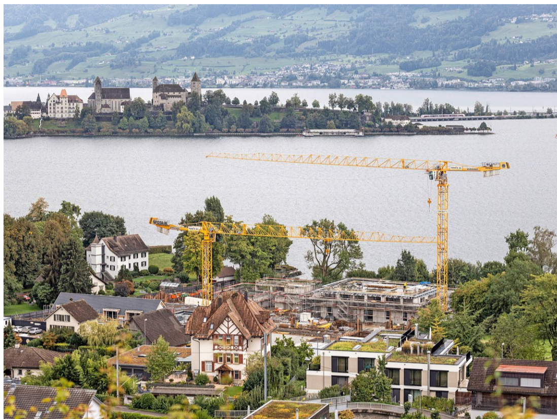
Zu den gebauten Häusern soll auf dem Grundstück in Kempraten noch ein Bootshaus mit Steg dazukommen. Foto: Patrick Gutenberg
