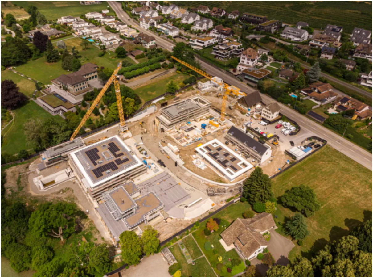
Le site est encore un grand chantier. La date d'emménagement des Federer n'a pas encore été fixée. image: ch media
