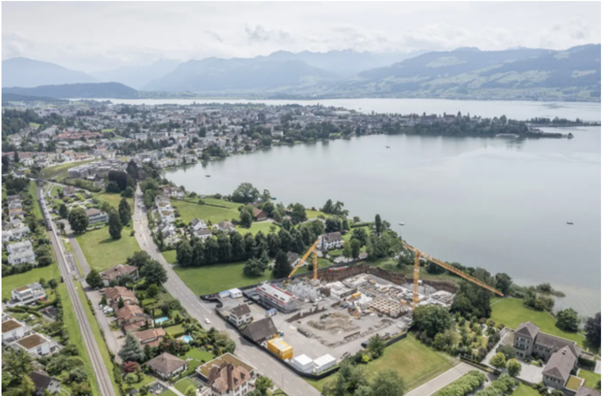
Juillet 2021: une maison a déjà été construite, les premiers contours des autres sont visibles. image: keystone
