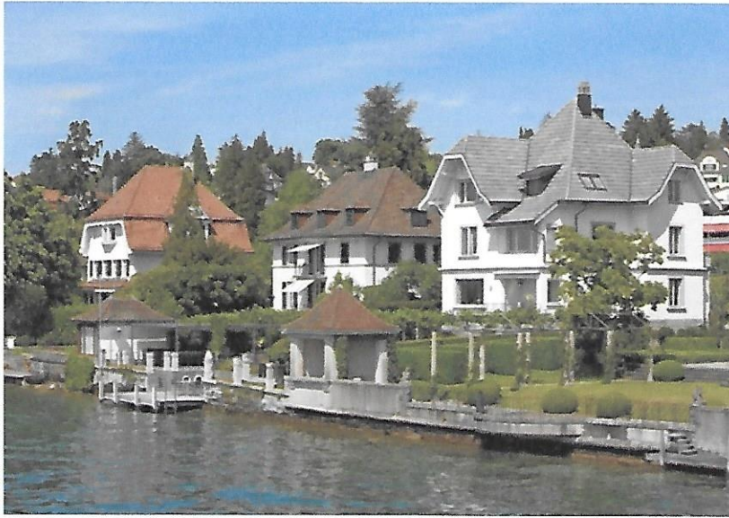
Bei Umbauten mischte sich hier bis anhin der Kanton ein: Villen am Seeufer in Zollikon. Bild: Carophoto
