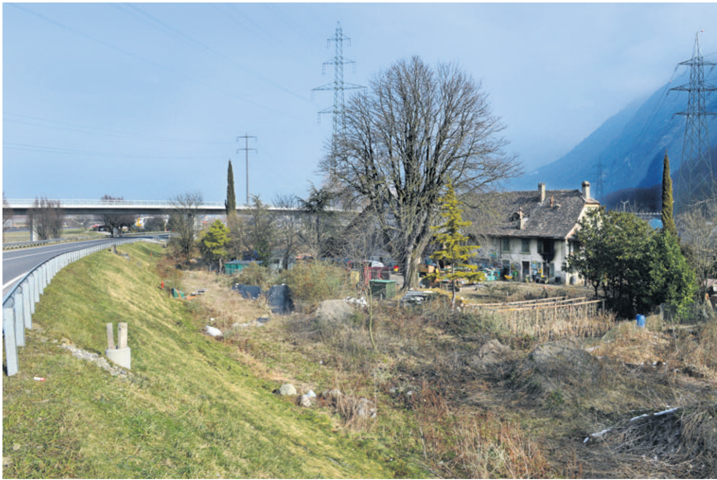
Le propriétaire de la ferme qui tombe en ruine a jusqu'au 30 mai pour la détruire entièrement. CHANTAL DERVEY
