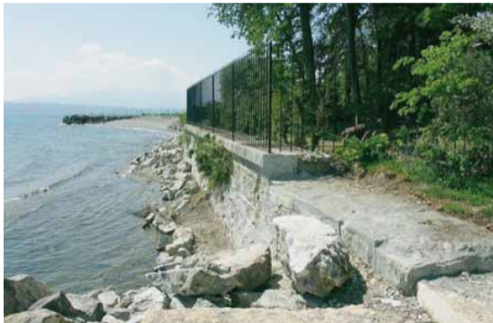
La plage de la Bécassine à Versoix est amputée de moitié suite à des travaux de renaturation de l'embouchure. DR
