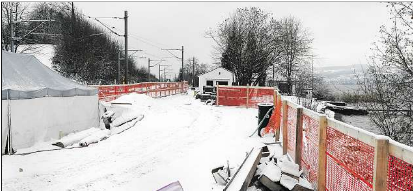
Geht das Geld aus, muss der Kanton den Bau des Zürichseewegs stoppen. Im Bild die Richterswiler Müleneren, wo der Weg bereits am Entstehen ist. (André Springer)
