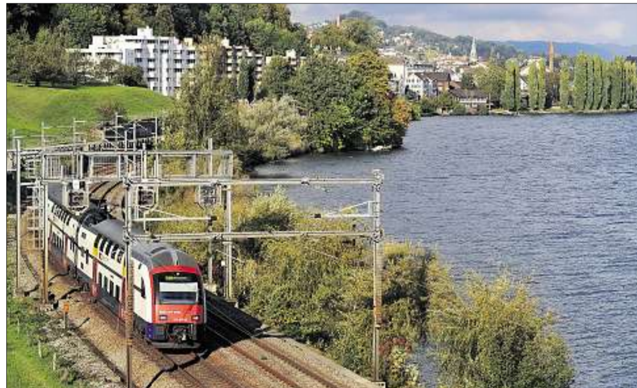
Von der Giessenhalbinsel in Wädenswil (hinten rechts) bis zur Mülener in Richterswil ist ein 1,6 Kilometer langes Teilstück des Uferweges bereits konkret geplant. Nächstes Jahr sollen die Bagger auffahren. (Manuela Matt)
