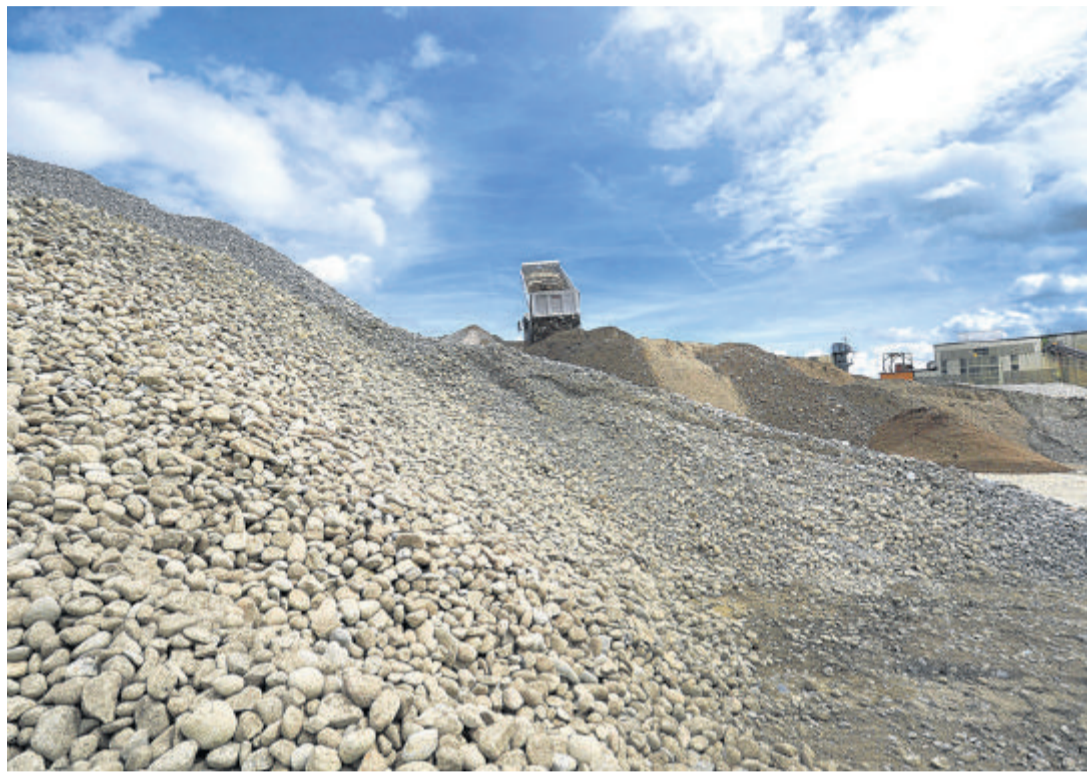
La zone de traitement du gravier de la Ballastière, à Gland. ALAIN ROUËCHE
