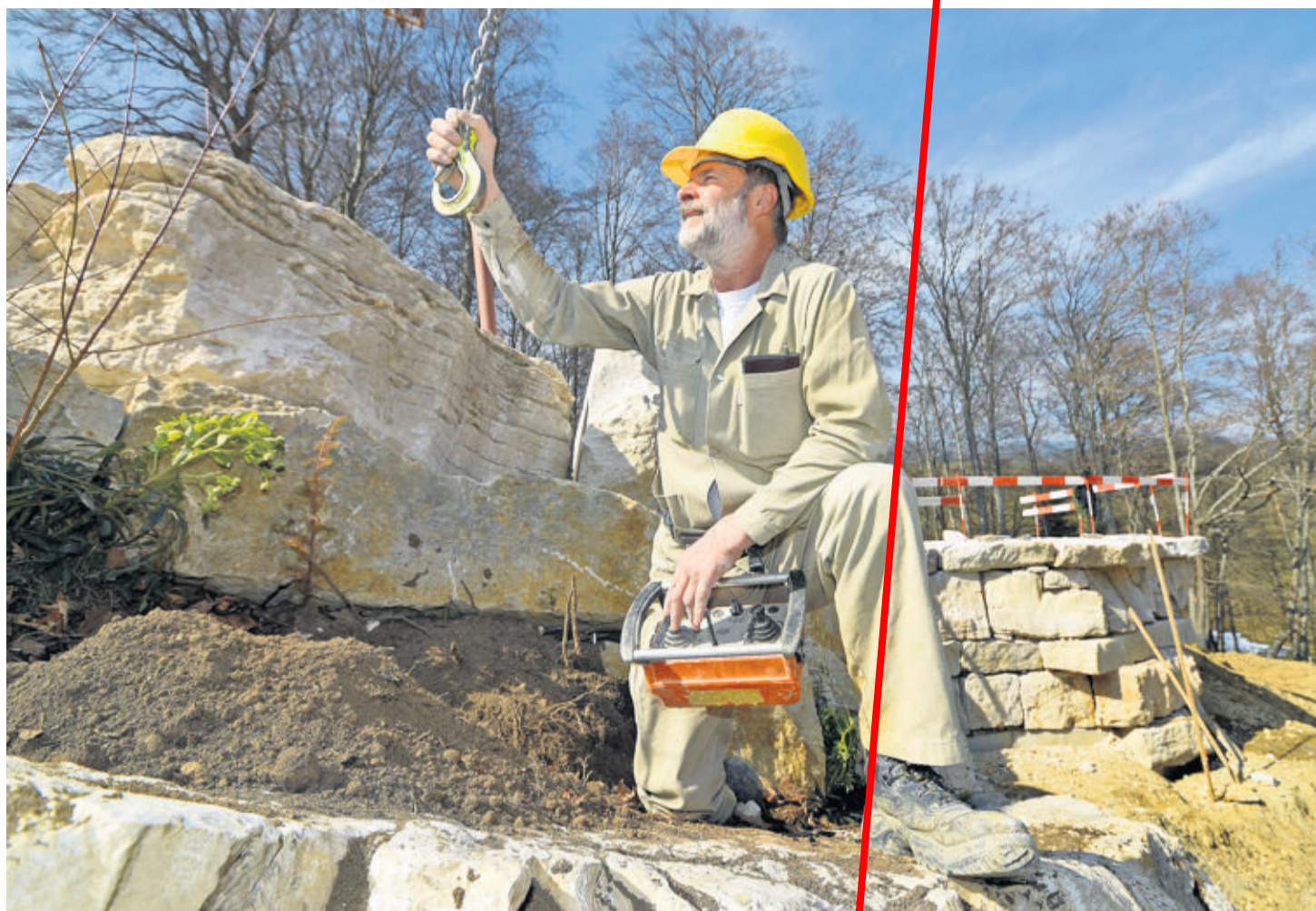
Le tailleur de pierre Luc Chappuis réalise les falaises du nouveau Zoo La Garenne, à Le Vaud. CHRISTIAN BRUN
