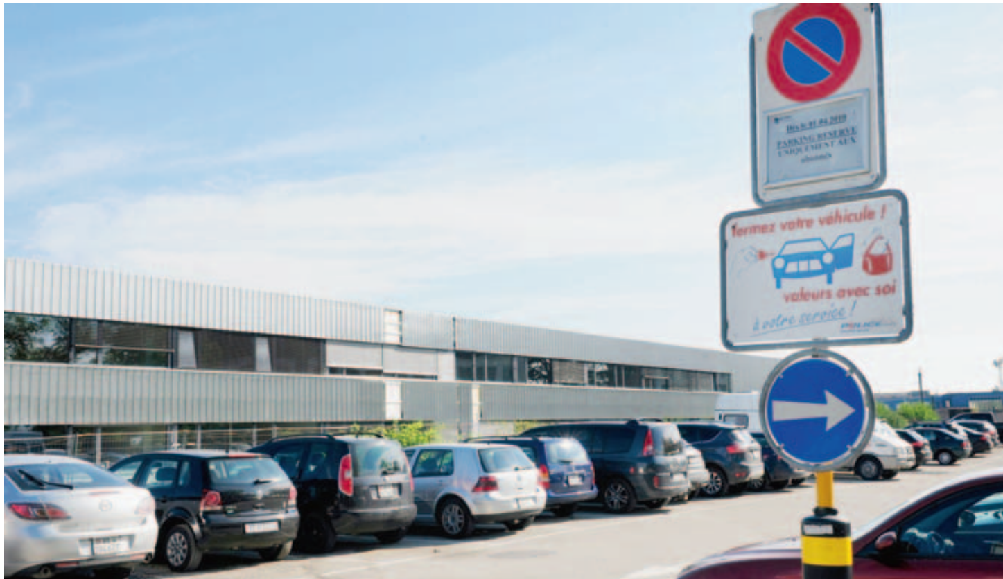
La première partie de l'extension du gymnase à peine terminée (ici en arrière-fond), voilà que la construction des salles de gymnastique se dessine. Ces nouvelles constructions prendront la place de l'actuel parking des Ruettes et seront livrées pour la rentrée 2014. AUDREY PIGUET
